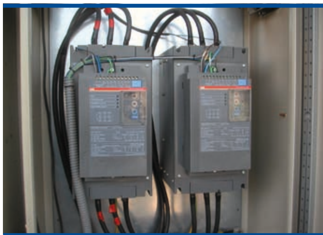
Foto 12. Arrancadores electrónicos
