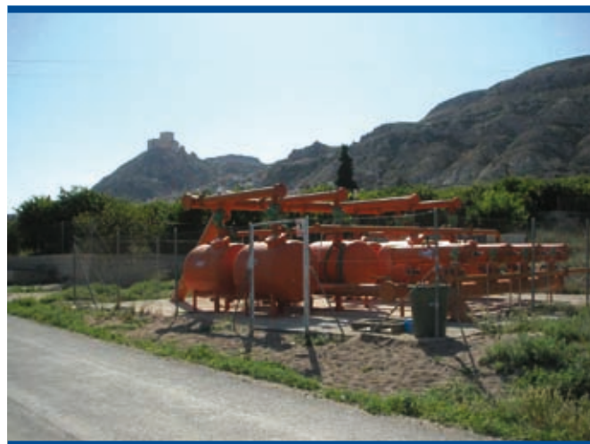
Foto 8. Estación de filtrado en un sector de riego de la comunidad de regantes de Mula
