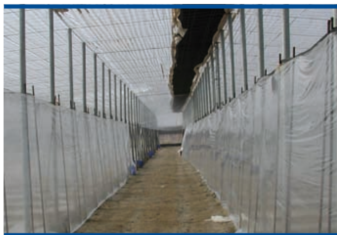
Foto 13. Particiones interiores con láminas de polietileno dentro de un invernadero
