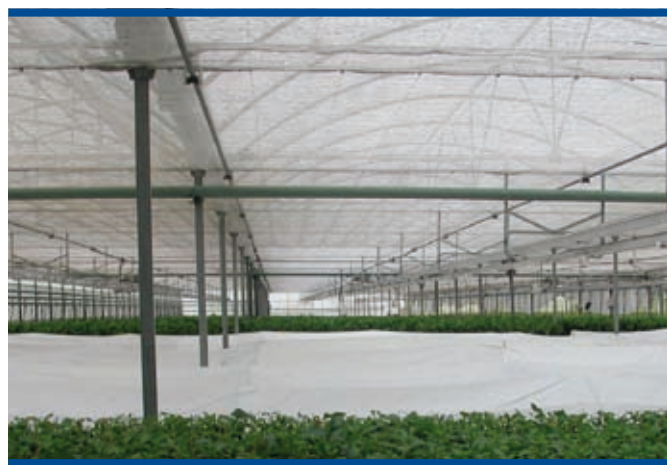
Foto 11. Invernadero con microtúneles y pantalla térmica
