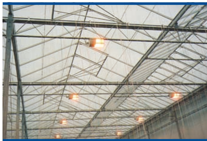
Foto 23. Instalación de focos para realizar iluminación artificial en un invernadero destinado a plantas ornamentales
