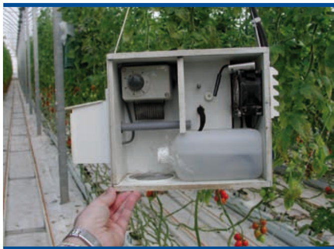
Foto 16. Caja de protección de las sondas de temperatura, con aspiración de aire
