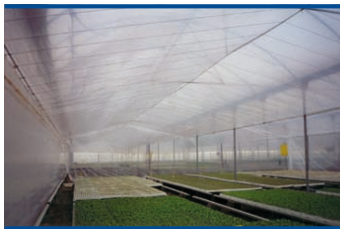
Foto 10. Instalación de un doble techo en un semillero comercial
